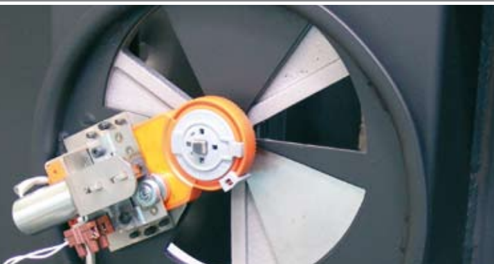
Verbrennungsluftdosierer offen
