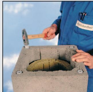
43 При монтаже готовой покрывной плиты установите дубели в отверстия верхней каменной оболочки.
