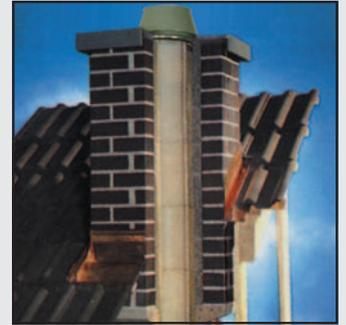
52 После облицовки дымохода в качестве завершающего элемента используйте покрывную плиту и конус. Покрывную плиту Вы можете получить в виде готового элемента или изготовить непосредственно на месте. В «Комплекте для монтажа верхней части дымовой трубы» содержится отдельная инструкция по бетонированию покрывной плиты на строительной площадке.
